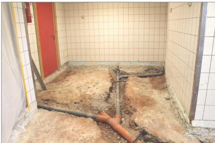
Il a fallu sortir au marteau piqueur la dalle bétonnée du sol afin d'y installer de nouveaux tuyaux d'évacuation.
