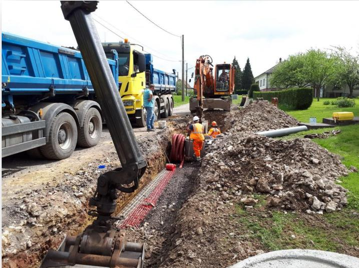
Pose d'une conduite de refoulement Diamètre 110 et TPC de 90
