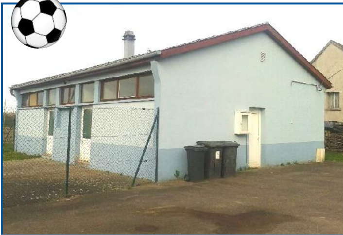
Les vestiaires de foot ont été construits en 1965
