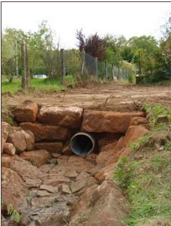
*Un terrassement en pierres de l'arrière du fossé permet le bon écoulement des eaux et évite les inondations sur le terrain et jardin à proximité. Travaux effectués par l'entreprise GREBIL de Goetzenbruck pour un montant total TTC de 5 678,13 €.*
