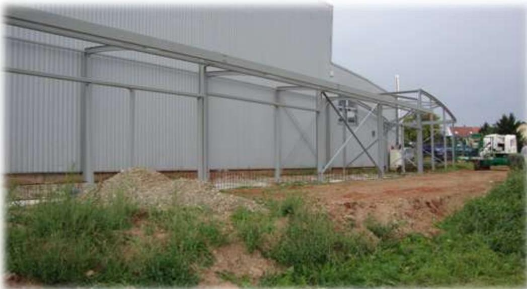
Les travaux d'extension de la salle polyvalente ont débuté le 21 juin dernier. L'entreprise GREBIL de Soucht a réalisé les fondations et l'entreprise METZGER de Stattmaten (67) a procédé au montage de la charpente métallique ainsi que du bardage.
