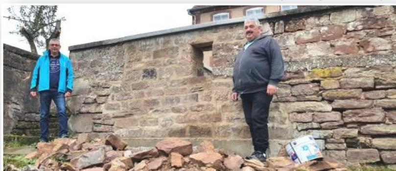
Le mur d'enceinte (partie arrière du bâtiment) du presbytère très endommagé par les intempéries est en cours de restauration par le service technique de la commune. Pierre par pierre il faut reconstruire le mur avec au préalable une bonne fondation en béton.
